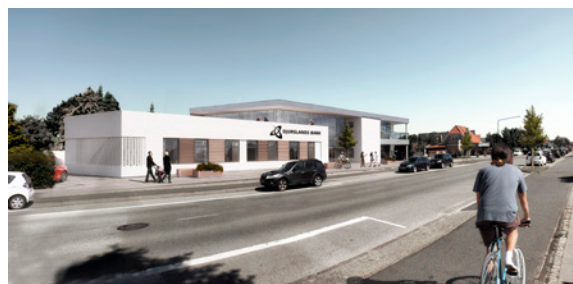
Visualisering fra SPOT architecture: Byggeriet på Nordre Strandvej i Risskov er ved at tage form, og udvidelsen blev markeret med et rejsegilde fredag 7. december 2018.
